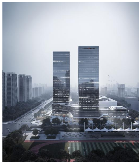
图：西安科研中心项目包含集中太阳能热水系统、雨水回收利用系统，太阳能热水系统年预计提供热水 6,108.69m 3 ，雨水回收利用系统回收及处理雨水将用于公共区域冲洗、绿化浇灌等，同时通过海绵城市设计，将屋顶及道路雨水引入场地绿化区域，控制雨水径流及污染物，并对雨水再利用
