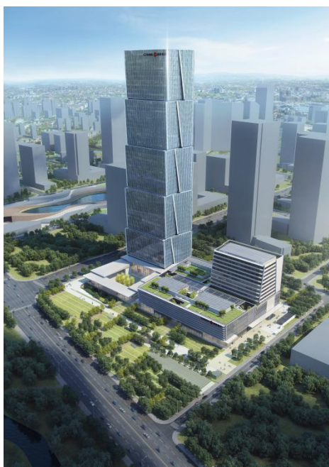
图：钱江世纪城总部大楼项目幕墙采用双中空玻璃进行系统设计，有效提高外墙节能性能。该项目获美国绿色建筑认证体系 LEED 金奖预认证
