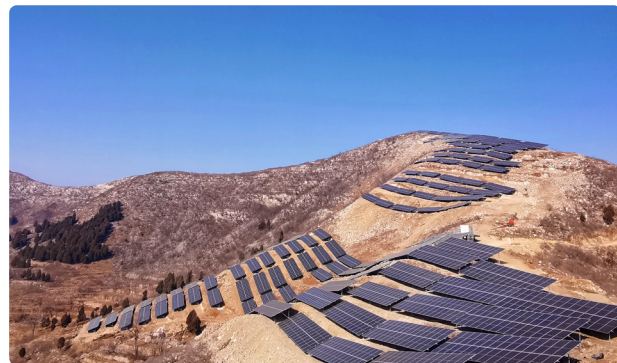
阳光电源股份有限公司光伏电站项目，预计每年可实现碳减排15.38万吨
