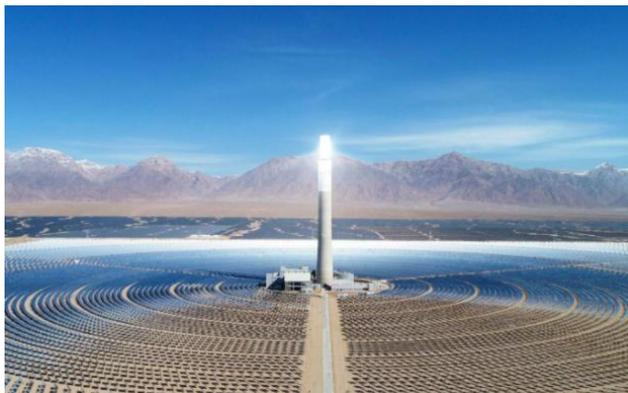
圖：可勝技術建設的塔式熔鹽儲能和光熱項目全貌
